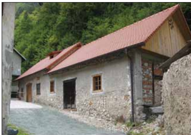
Po zadnji povodnji obnovljeni Bodlajev vigenjc v Kropi.
