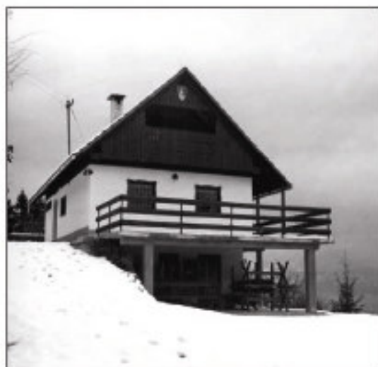
Leta 1974 so leseno kočo porušili, povečali kletne prostore in postavili večjo zidano stavbo. Petelinovec 1979.
